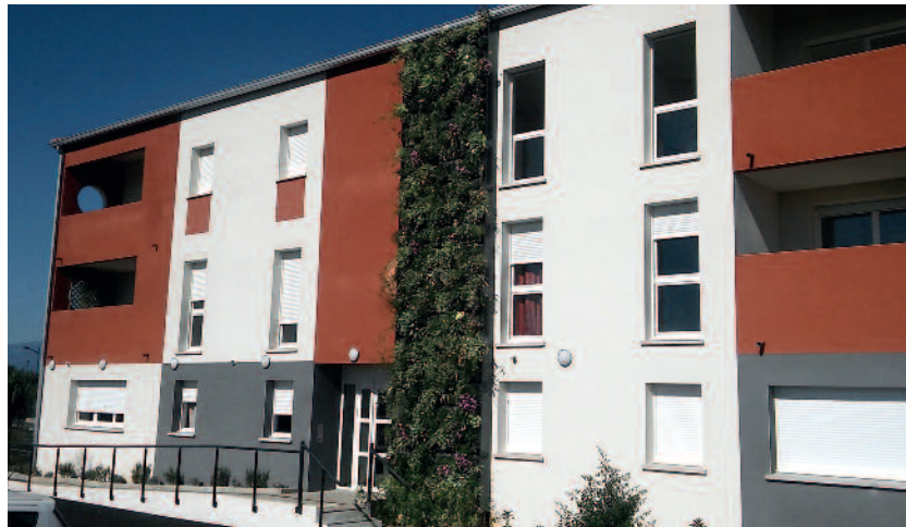
Ce mur végétalisé de deux mètres sur neuf a été réalisé cette année pour Bouygues à Alenya.
